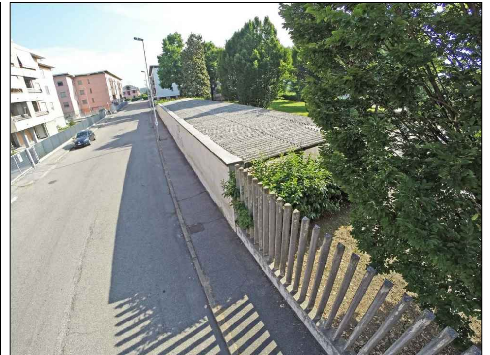
205 - Tettoia su via Moncalvo
