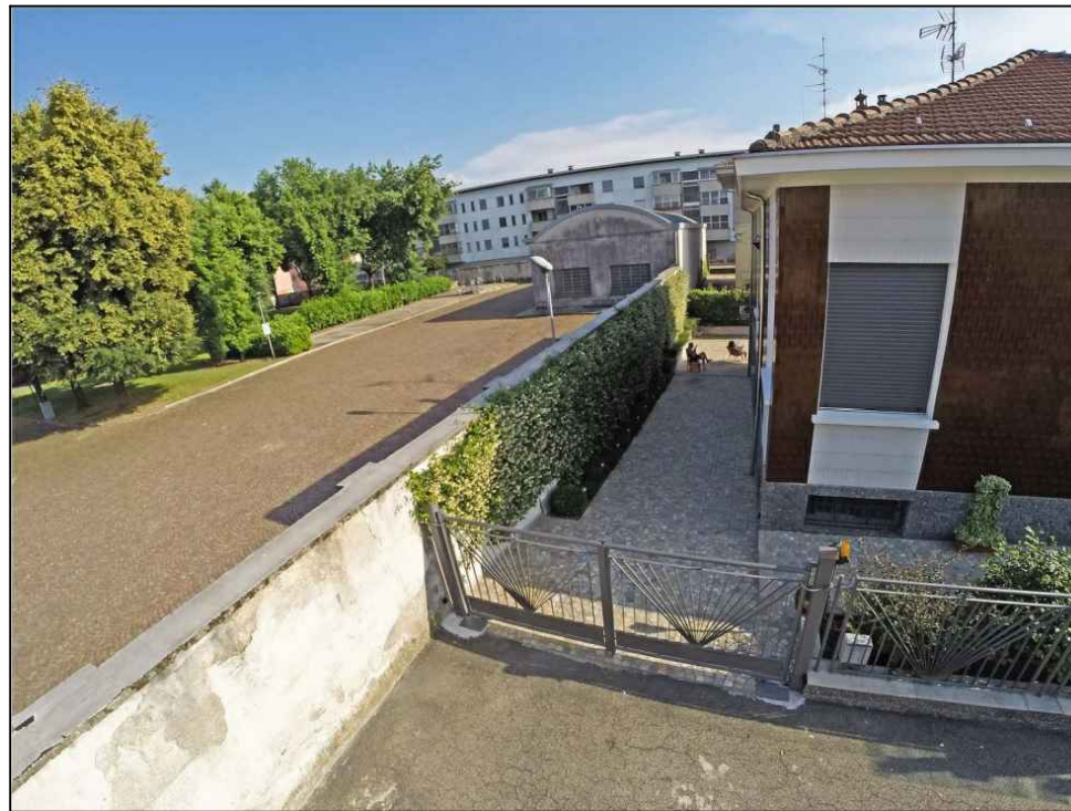
403 - Lato Est del lotto
