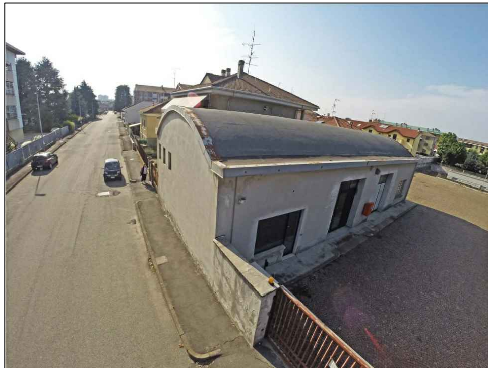
204 - Deposito su via Giusti e accesso esistente
